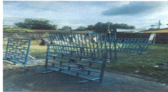
FOTO 4: Fabricación e instalación de balcones de hierro en ventanas
