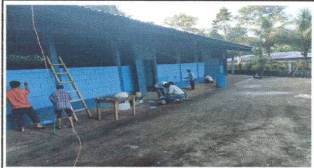
FOTO 8: Pintura de muros exteriores e interiores
