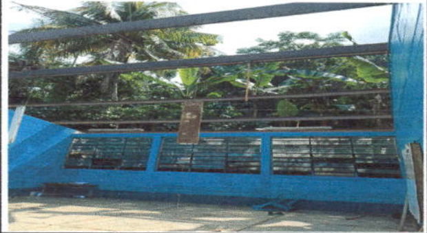
FOTO 2: Mantenimiento a estructura de soporte de metal
