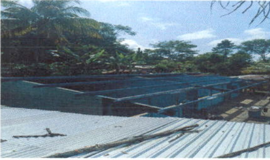
FOTO 1: Sustrucción de lámina por lámina troquela modulo 1
