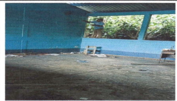
FOTO 9: Pintura de muros exteriores e interiores
