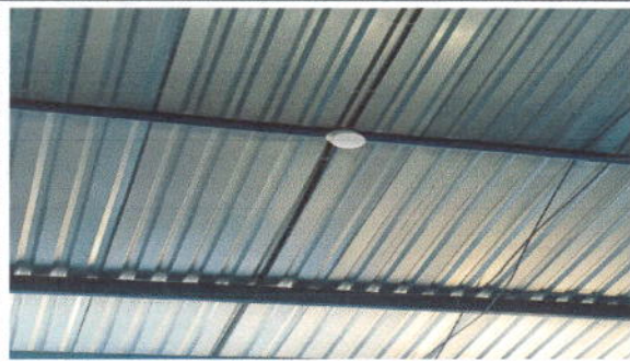
FOTO 7: Reparación de sistema eléctrico modulo 1
