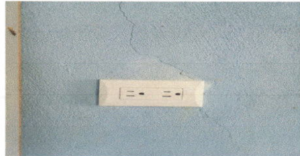
FOTO 6: Reparación de sistema eléctrico
