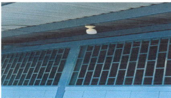
FOTO 5: Reparación de sistema eléctrico modulo 2
